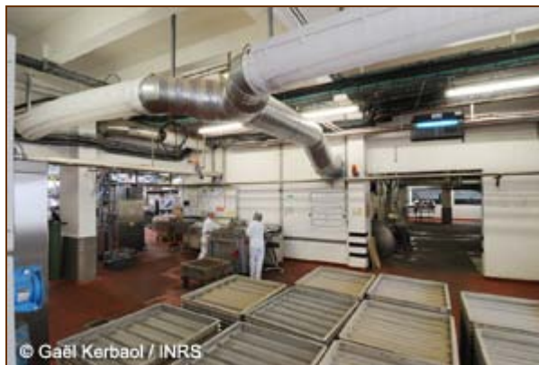
Système de ventilation et d'aération dans l'agroalimentaire
